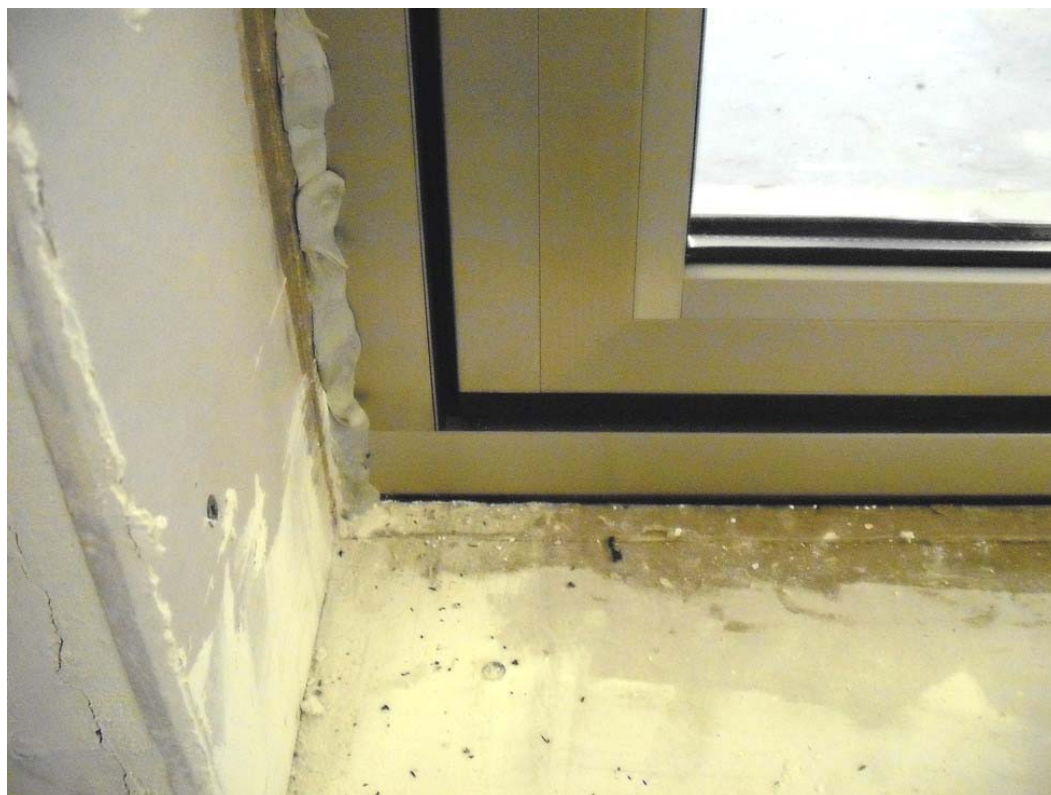
Bild 4: Ansicht Empfangsraum, Detail Anschluss Boden
