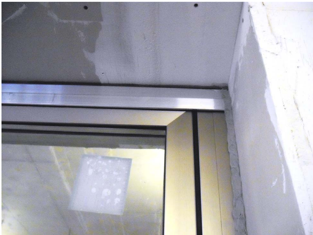
Bild 2: Ansicht Senderraum, Detail Anschluss Decke
